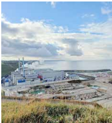
Penly : le chantier a commencé
