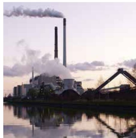
Une nouvelle centrale au charbon de 1 100 MW de puissance a été mise en service à Datteln dans l'ouest de l'Allemagne le 30 mai.
