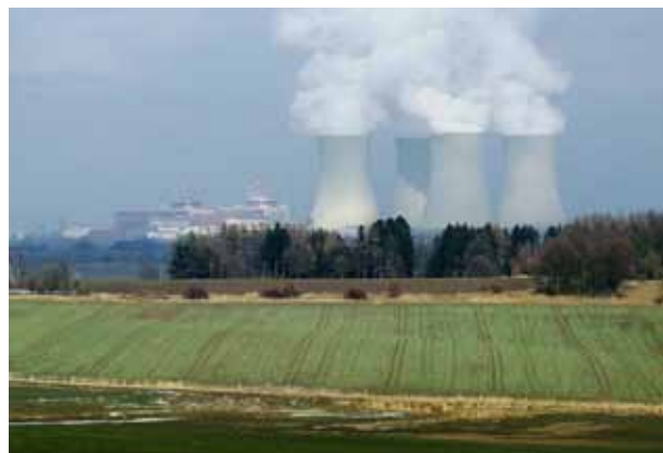
Centrale nucléaire de Temelin.
