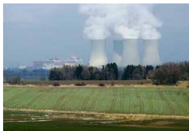
Centrale nucléaire de Temelin.
